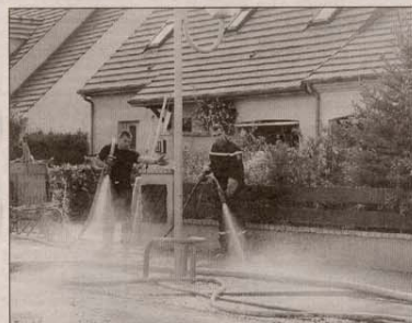
VILLIERS-LE-BÂCLE, HIER. Pendant près de quarante-huit heures, les pompiers se sont relayés pour pomper les nappes d'eau, déboucher les évacuations, assécher les caves et les parkings... (L.P./G.P.)
